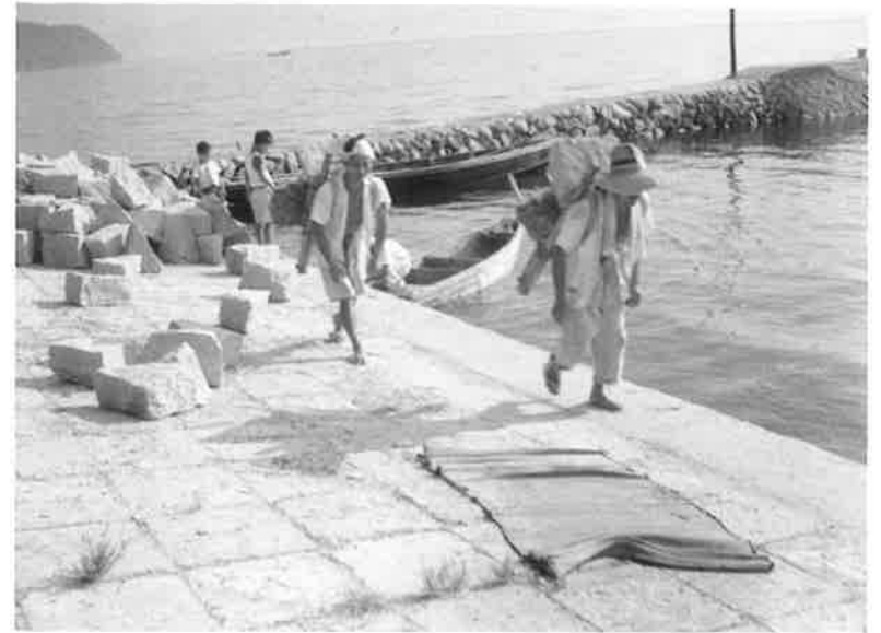
①柱島港の風景。撮影当時の港はコンクリートではなく切石を敷き詰めている。小船から荷揚げして人の手によって背負子で運んでいる。背負子は今でも使われていることがある。
